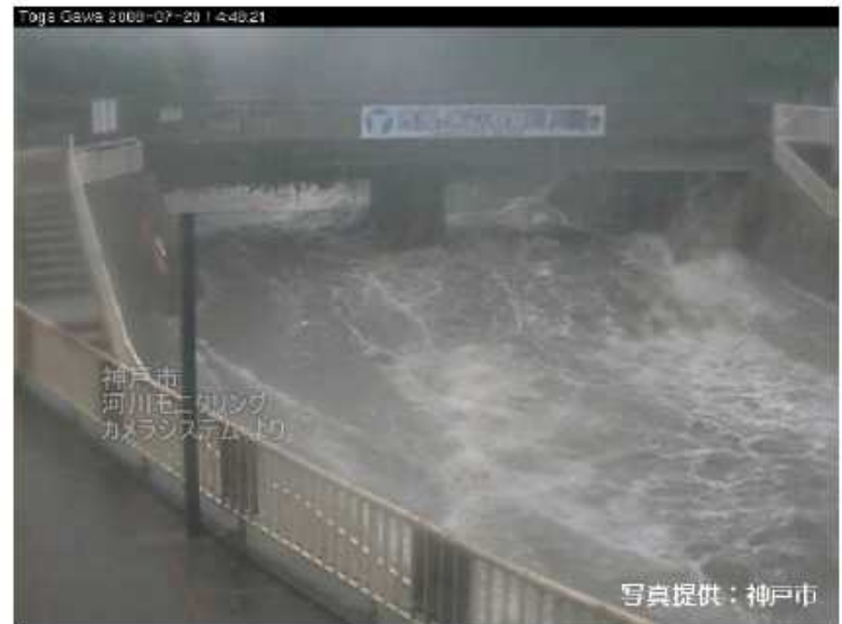
増水時の都賀川（写真提供：神戸市）
